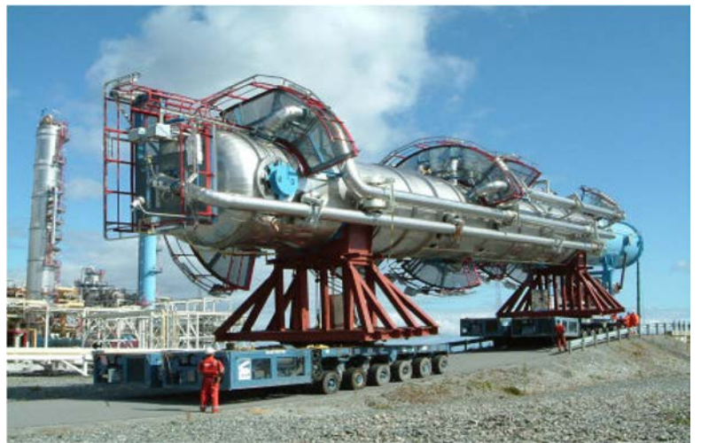
図1 ドレスアウト工法
