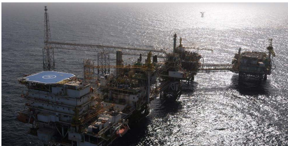
図6 エル・ブンドク油田 中央処理施設 俯瞰写真 (出典：ブンドク社ホームページ)
