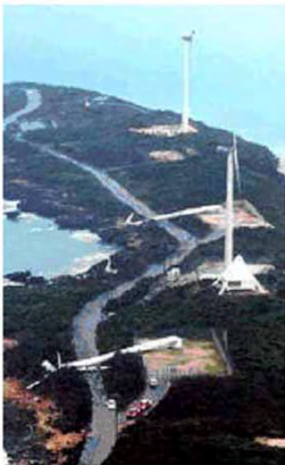
台風で根元から倒れた風車 =03年9月、沖縄県・宮古 島で、本社機から
