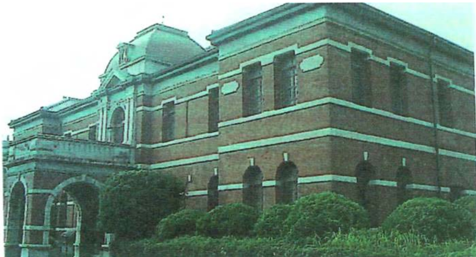
(写 - ) 前面道路から見た景観
