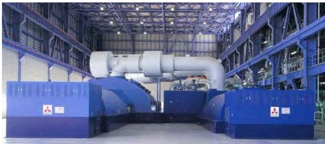
写真31 電源開発橘湾2号1,050MWタービン [提供] 三菱重工業(株)
