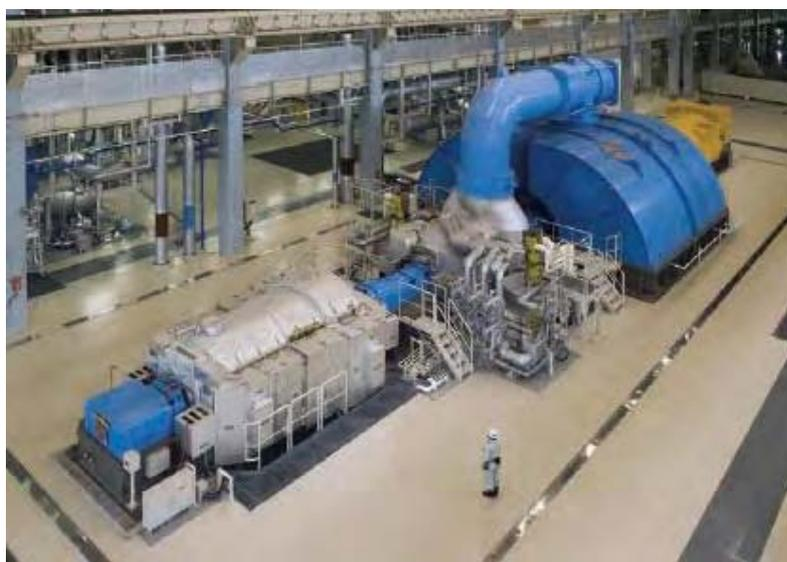
写真32 電源開発磯子新2号600MWタービン [出典] 「火力原子力発電」, Vol. 60, No. 11, (2009-11) (株)日立製作所納入
