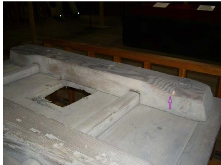
写真11 磨滅した踏板の部材
