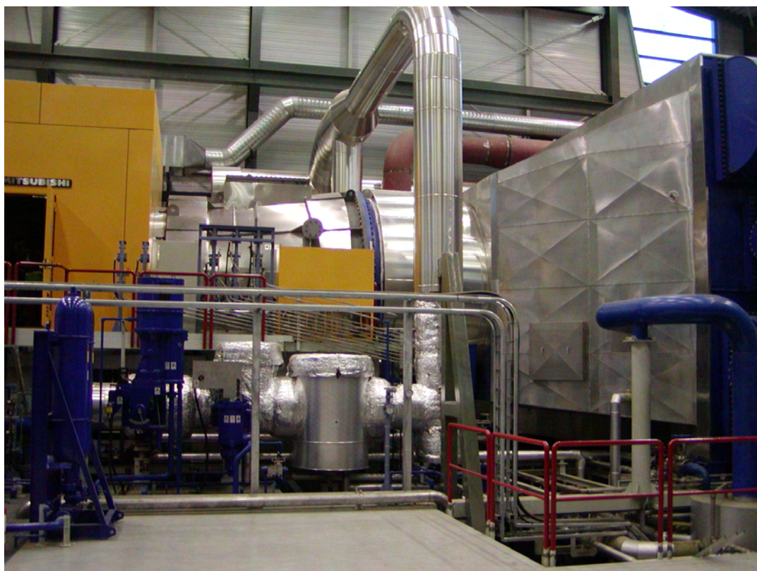
図9 Hellsheidi 発電所 45MW 軸流排気タービン [提供] 三菱重工業(株)長崎造船所
