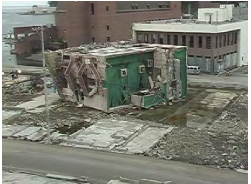
サイコロのように押し倒されたビル（女川町）
