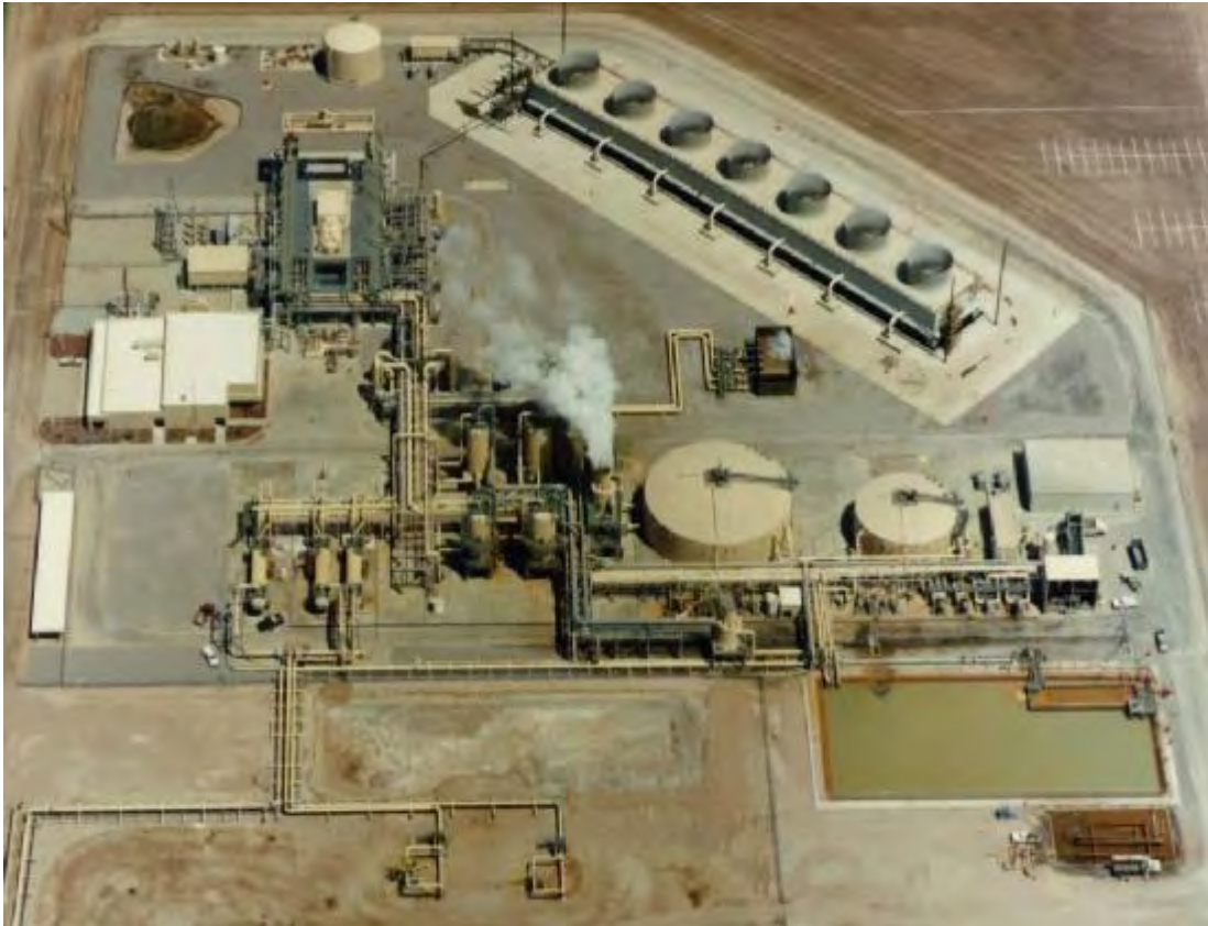
写真4 米国 Salton Sea 発電所蒸気・熱水処理装置
