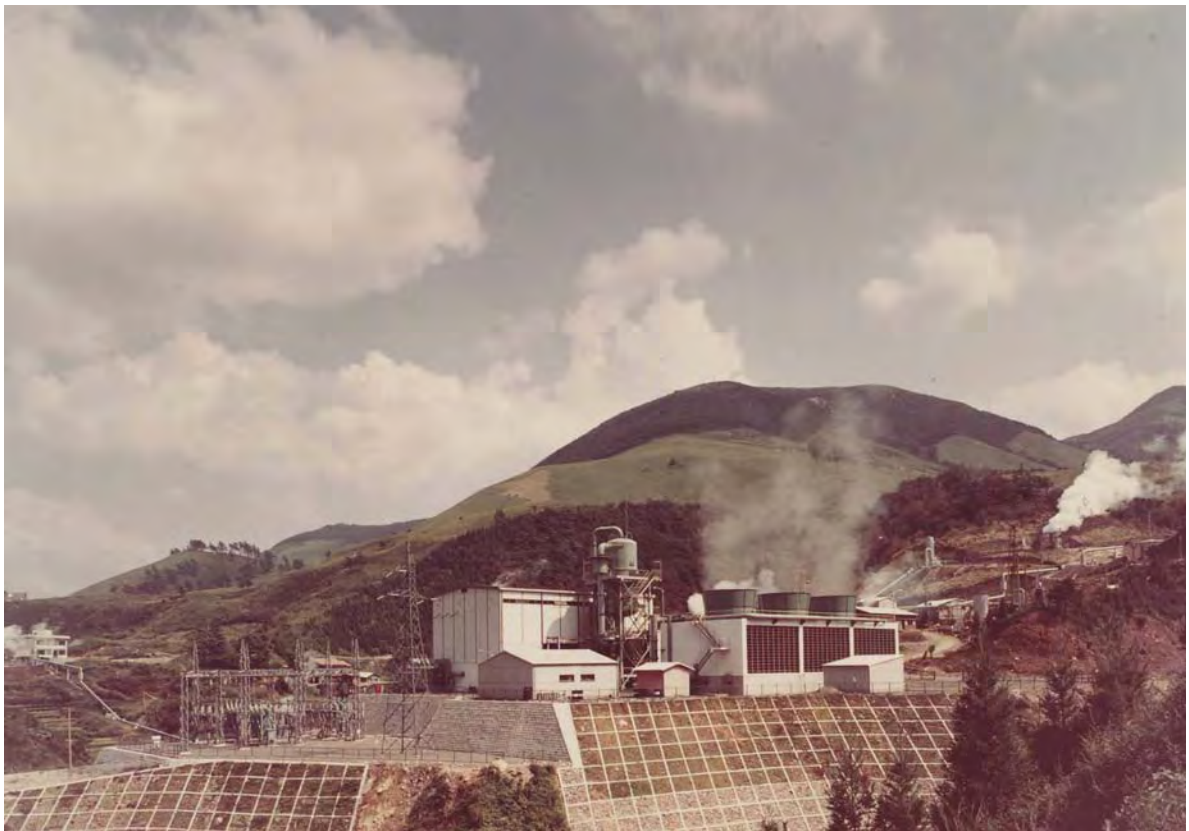
写真3 九州電力大岳発電所
