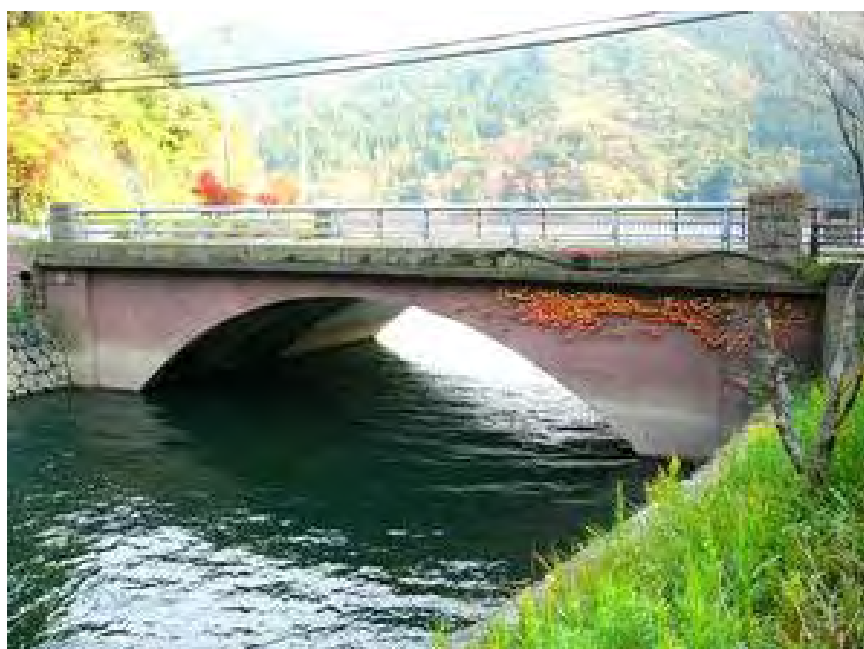
鉄骨コンクリート橋の北河内橋
