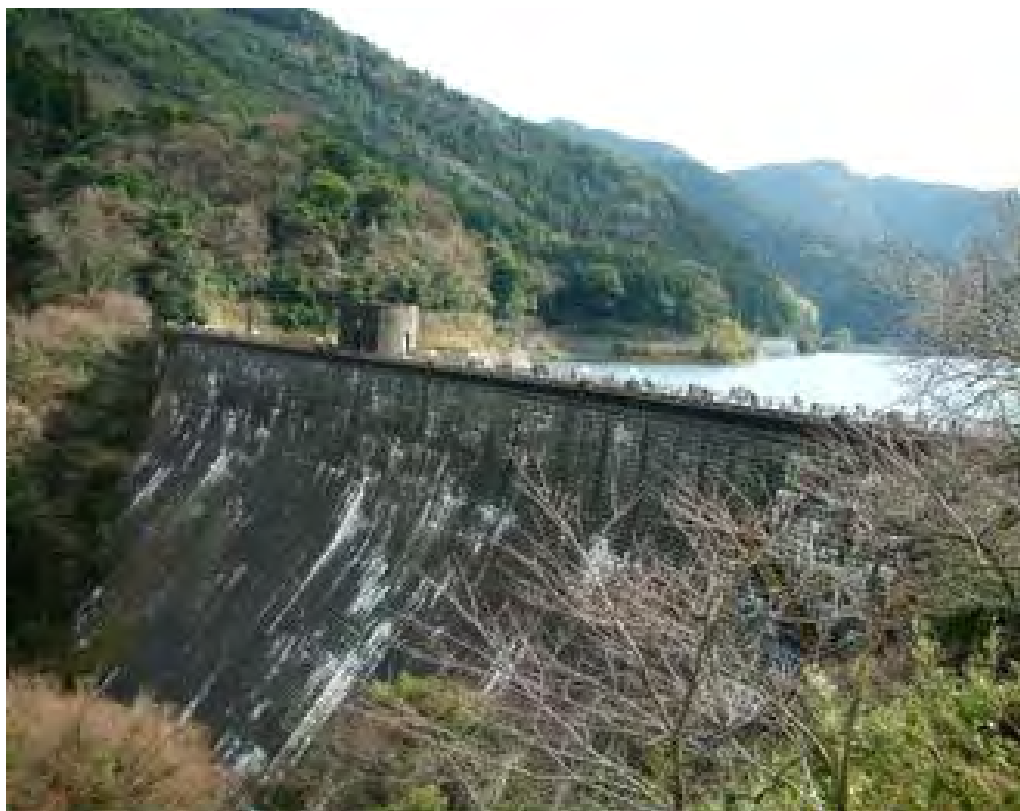
河内ダムと貯水池
