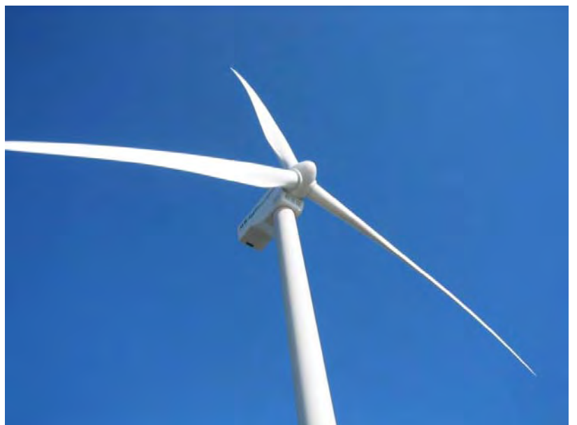
写真 5 日本最大の 2400kW 風車 (提供：三菱重工業)
