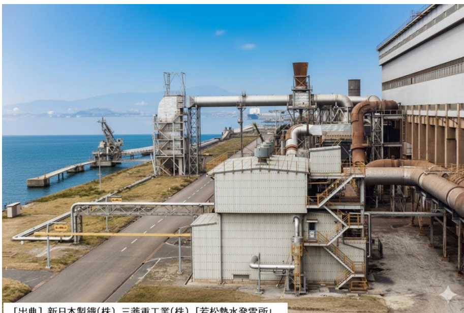
【出典】新日本製鐵(株) 三菱重工業(株)「若松熱水発電所」
