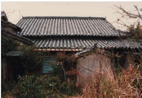
築100年超の実家 (平成3 (1991) 年解体)
