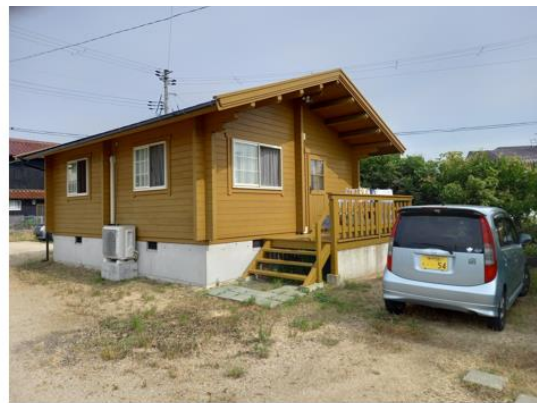
ログハウス (平成29 (2017) 年建設)
