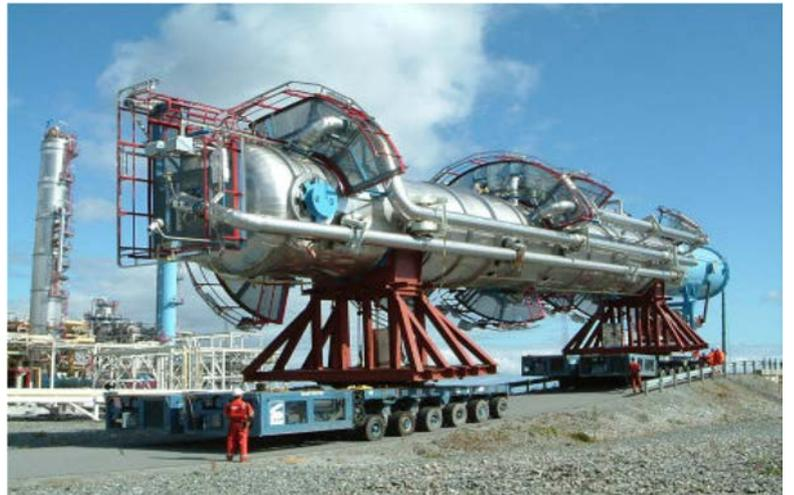
図1 ドレスアウト工法
