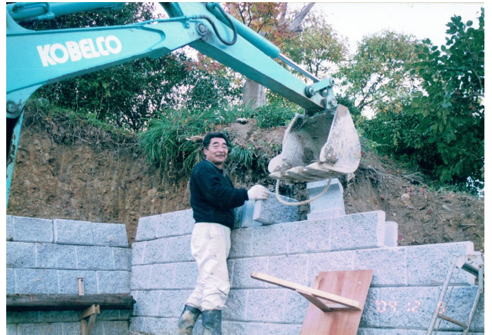
ショベルカーで 40kg/個のブロックを吊る
