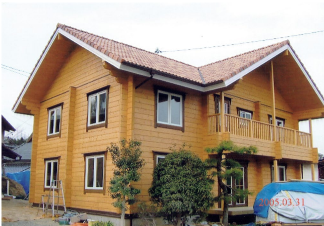
外装が完了したログハウス 右下のシートは内装用材料
