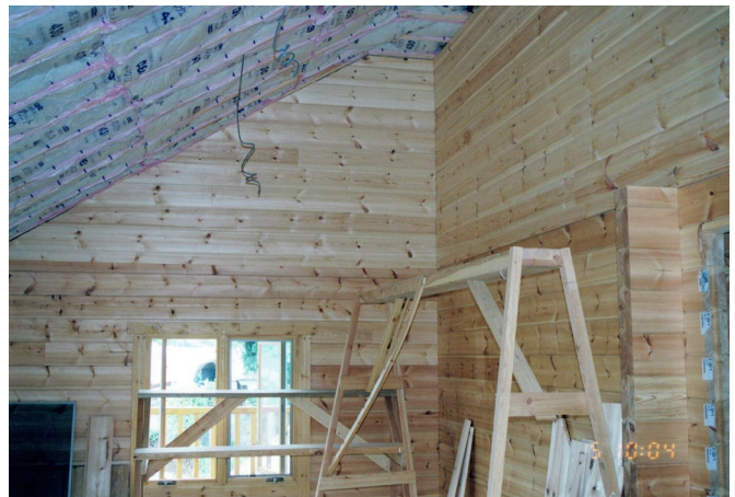
間仕切り作業を終えて天井貼り作業に掛る前 手作りの作業台
