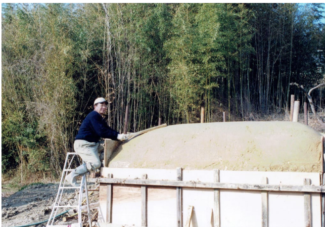
中子に固練りした土を載せて叩く
