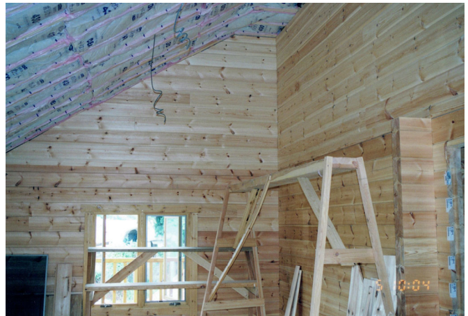
間仕切り作業を終えて天井貼り作業に掛る前 手作りの作業台
