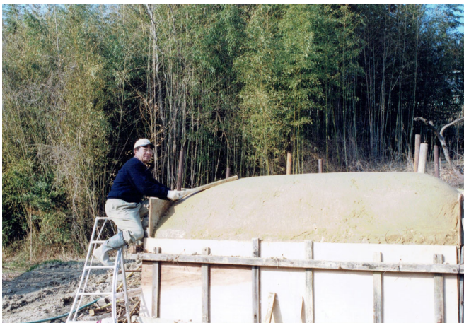
中子に固練りした土を載せて叩く
