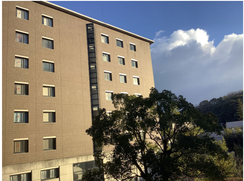
314教室から見た北棟
