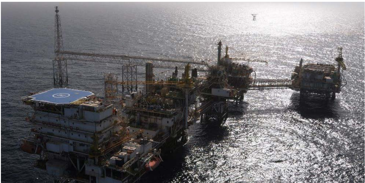
図6 エル・ブンドク油田 中央処理施設 俯瞰写真 (出典：ブンドク社ホームページ)
