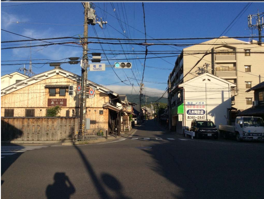
山陰街道 檜原より (2019年6月13日5時21分) 蛇足ながら、明智光秀が 本能寺に向かったこの街道 は立派なお屋敷が多いです が、電柱と電線がきたない です。
