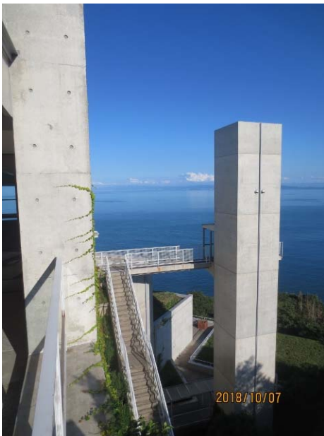
写真14 エントランスから 見たエレベータータワー
