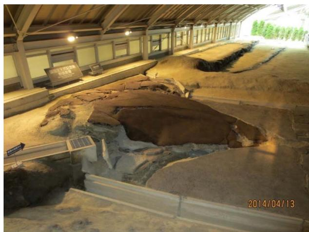
写真1 野島断層の活動によってずれた道路と側溝
