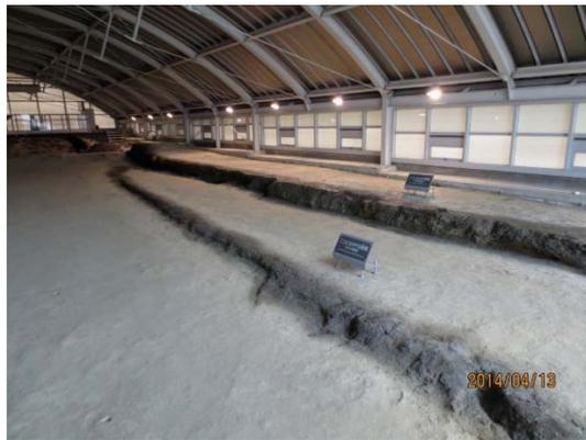
写真2 写真3 野島断層の活動によって生じた段差
