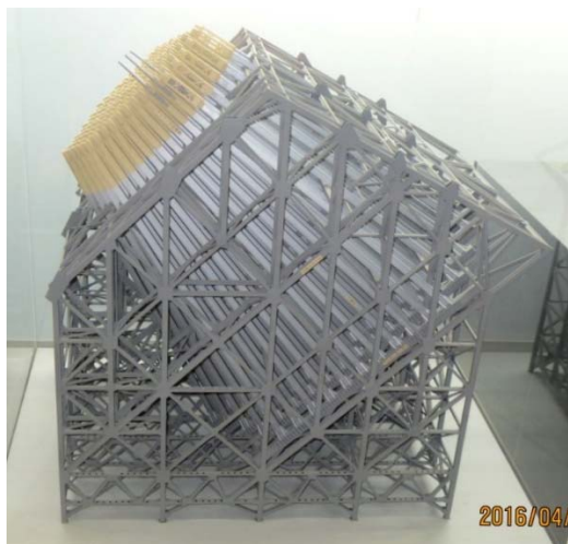
写真9 アンカーフレーム
