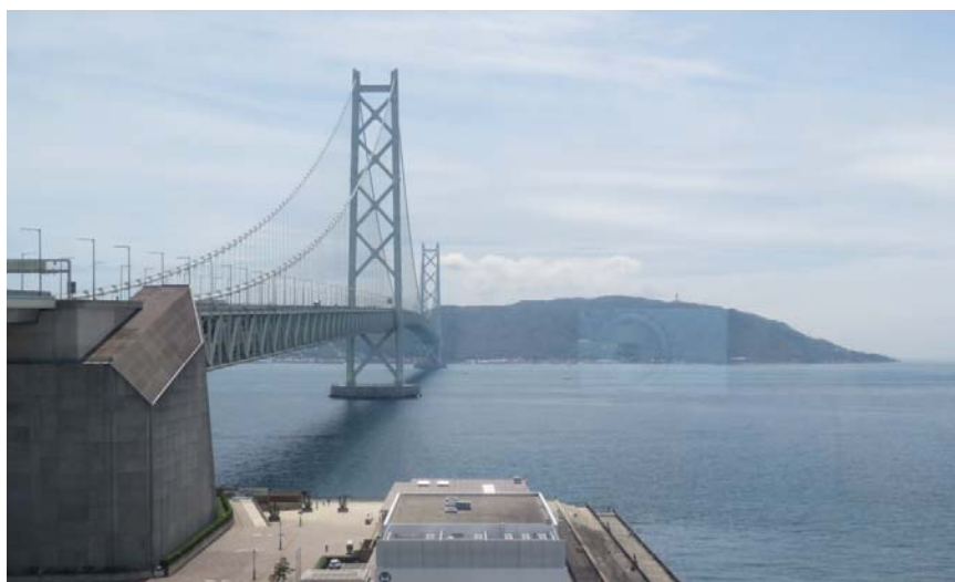
写真7 明石海峡と明石海峡大橋
