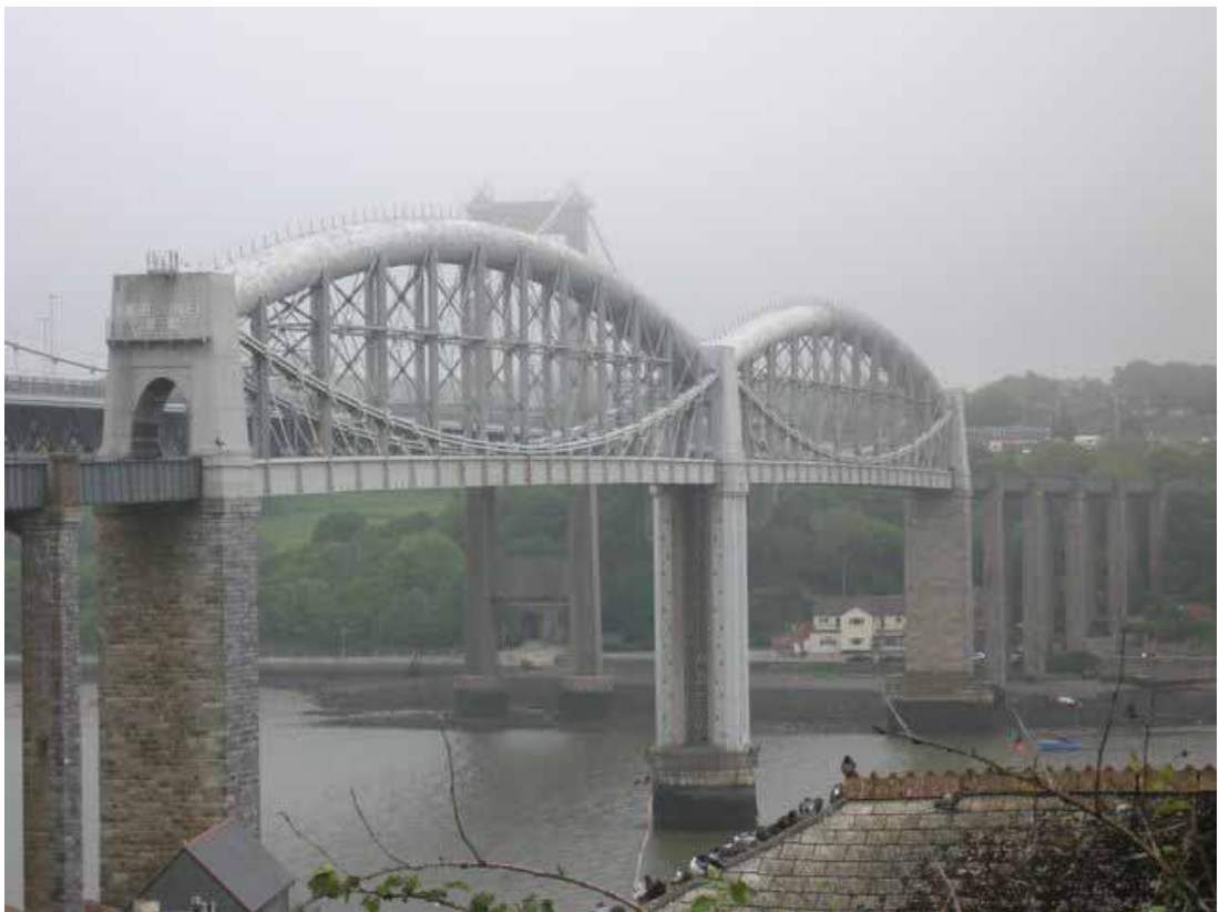
図 7 ロイヤル・アルバート鉄道橋
