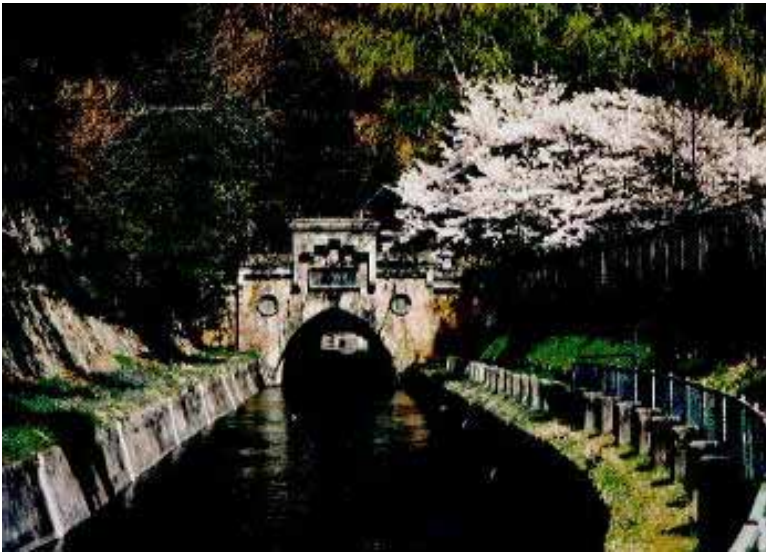
図 4-3 第 2 トンネル西口
