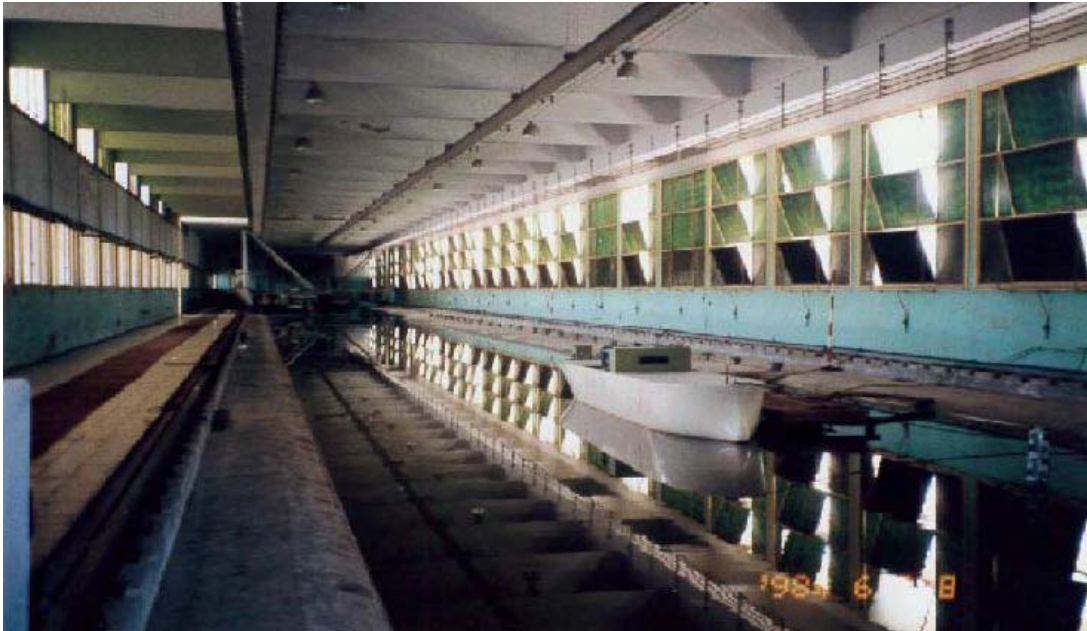
スエズ運河庁リサーチセンター実験施設
