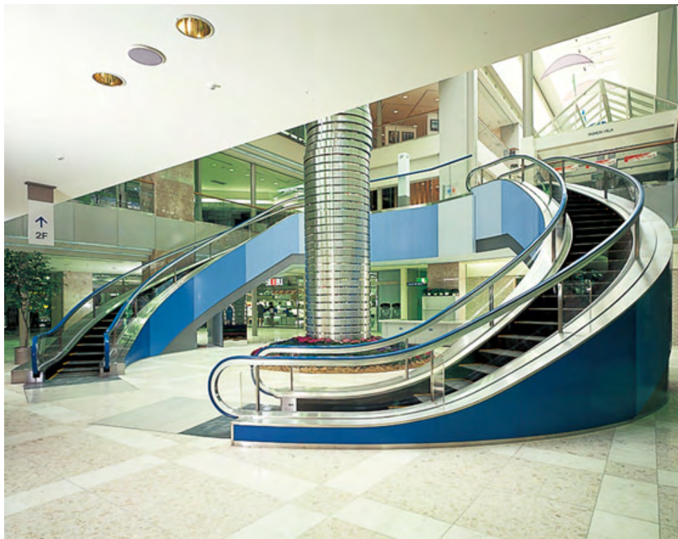
筑波ショッピングセンタークレオのスパイラルエスカレーター
