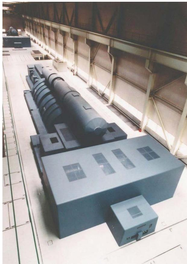
写真26 中部電力川越1,2号700MWタービン [提供] (株)東芝
