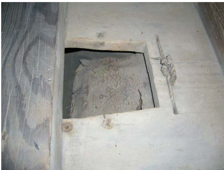
写真10 革が張られた逆止弁
